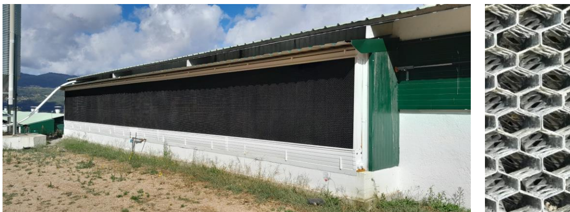
Figura 3.4.3. Painel evaporativo, ou cooling , existente na instalação. Pormenor.
