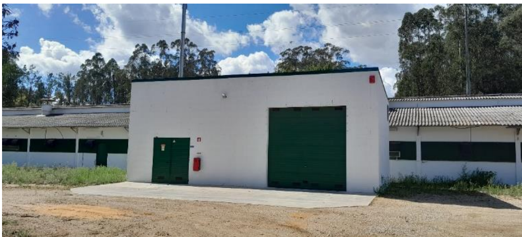
Figura 3.1.9. Um dos edificios da caldeira (21).
