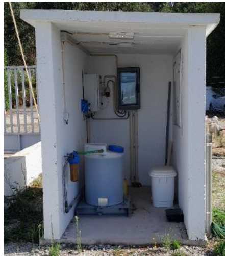
Figura 3.1.6. Edifício de apoio ao arco de desinfecção existente (16).
