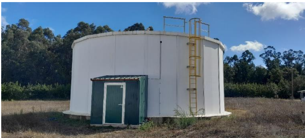
Figura 3.1.7. Reservatório de água existente (17).
