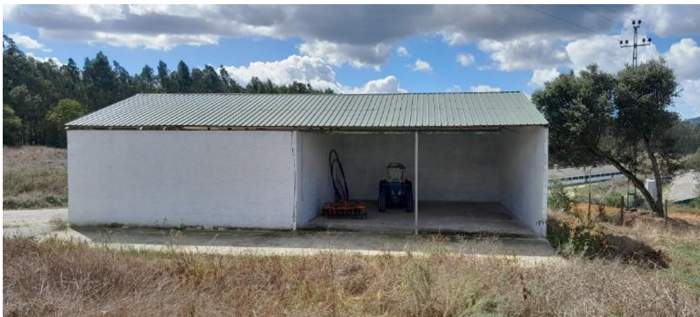
Figura 3.1.4. Um dos edifícios de armazens existentes (14).
