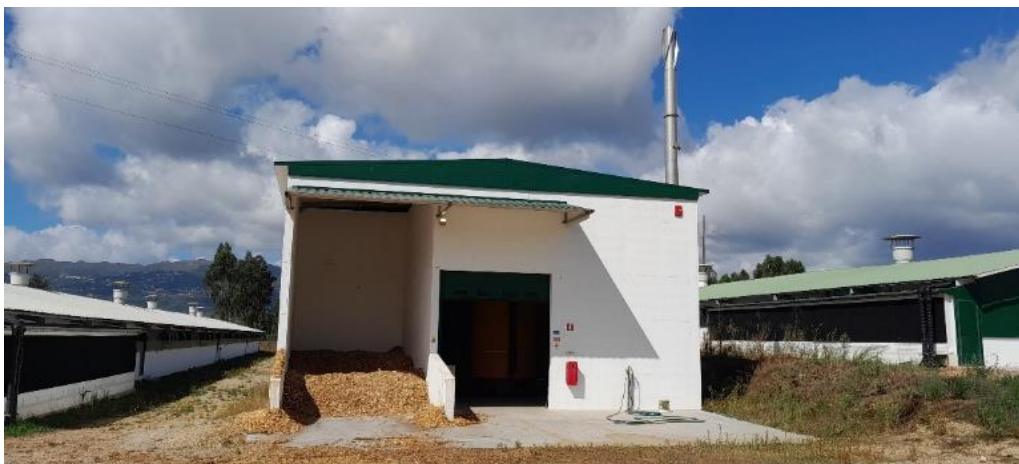
Figura 3.1.8. Um dos edificios da caldeira (18).
