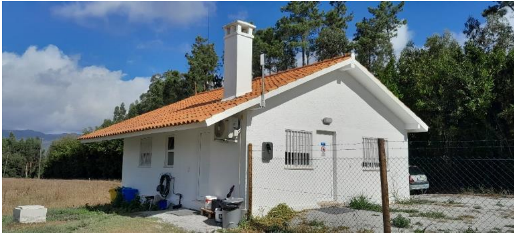
Figura 3.1.2. Edifício de apoio existente (12).
