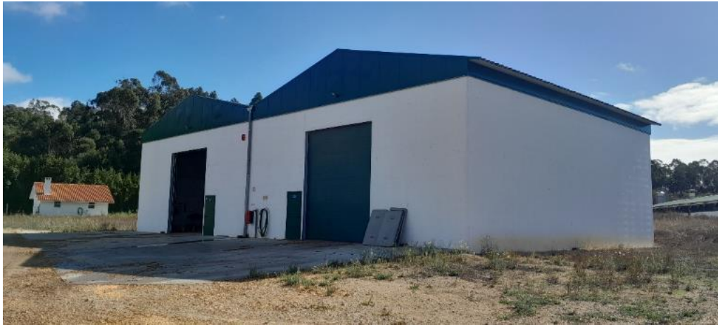
Figura 3.1.5. Um dos edifícios de armazéns existentes (15).
