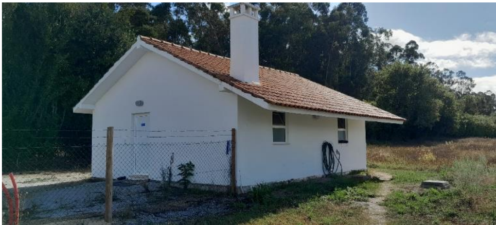
Figura 3.1.3. Filtro sanitário existente (13).
